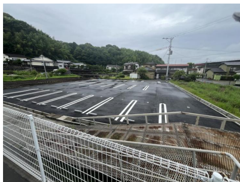
アスファルト舗装された駐車場
