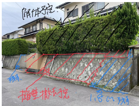
外観2 建物解体と2台平面に駐車できるように解体予定
