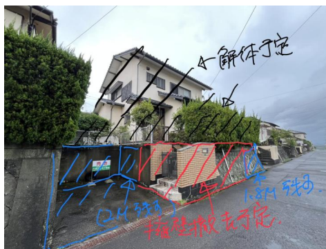
外観1 建物解体と2台平面に駐車できるように解体予定
